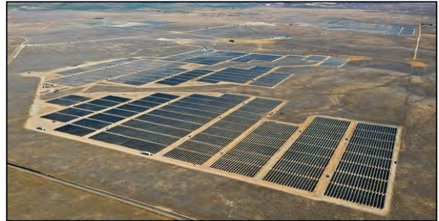
شکل 27: نیروگاه 250 مگاواتی کالیفرنیا در آمریکا
