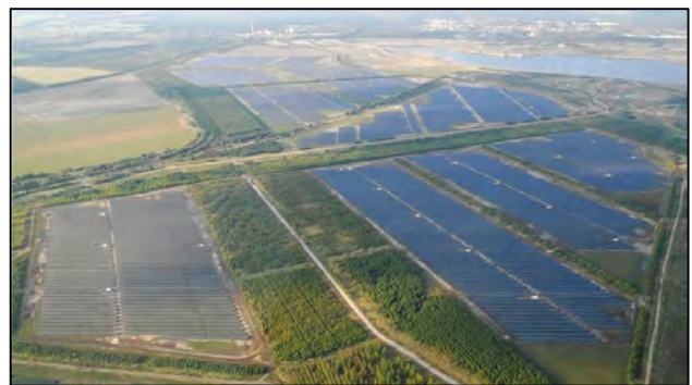
شکل 30: نیروگاه 166 مگاواتی موبرو در آلمان
