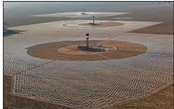
شکل 35: نیروگاه برج خورشیدی اویانپاسولار متشکل از سه واحد به ظرفیت مجموع 400 مگاوات در کالیفرنیا آمریکا [49]
